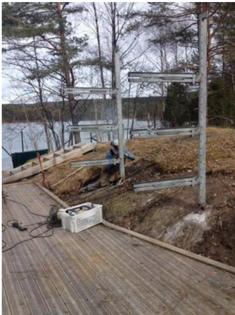
Nytt scullerstativ ferdig montert. Foto: Per Giltvedt
