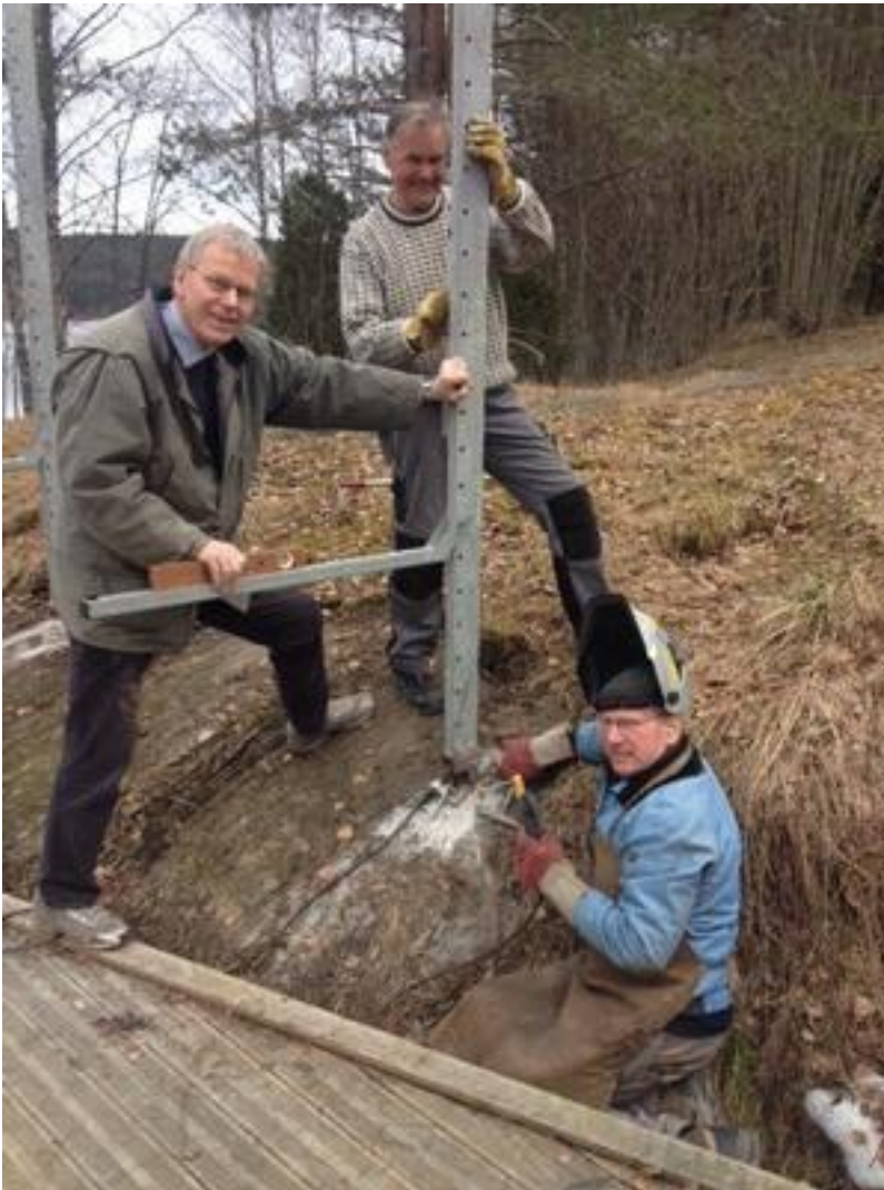
Nytt scullerstativ monteres. Fra venstre: Per Ulrikson, Ole Martin Berge og Torbjørn Ouren. Foto: Per Giltvedt
